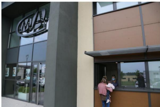
01 / 07 Mesures sanitaires obligent, la distribution se fait par une fenêtre, sans entrer dans les locaux. Photo Laurent MAMI
