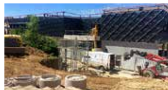
Construction du nouvel espace alimentaire du CFA de Metz.
